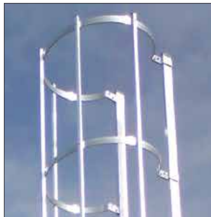
Høy ryggbøyle sikrer innstigningen til stigen
